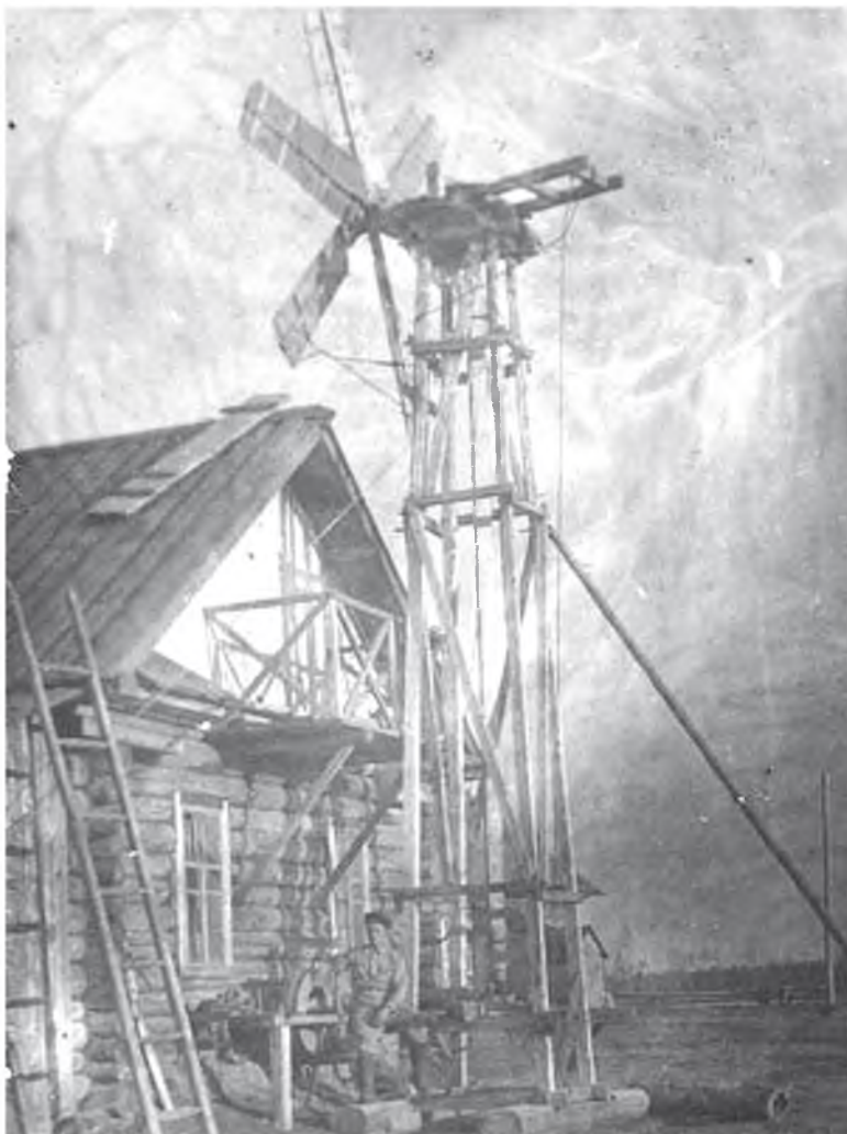
Ветродвиатель КУ-45 на метеостанции, деревянная конструкция для крепления двигателя, выполнена Кушниковым Б.П. и Угрюмовым Е.Н. Ветродвиатель выдавал электроэнергию для метеостанции и заряжал аккумуляторы. 14 июля 1945 год
