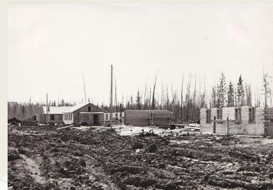
Строительство жилых барачков
